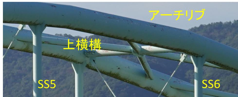
吊材の振れ止め材中間定着部
