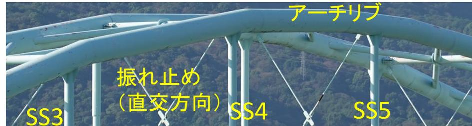
吊材の振れ止め材中間定着部
