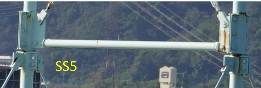
吊材の振れ止め材中間定着部
