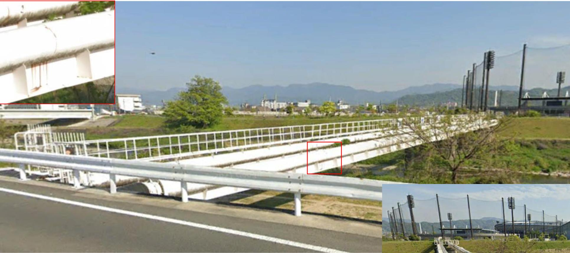
2本の通水管。1本は通水管の上に歩廊がある。もう1本は鋼桁の上に通水管があるように見える。錆汁が見える。
