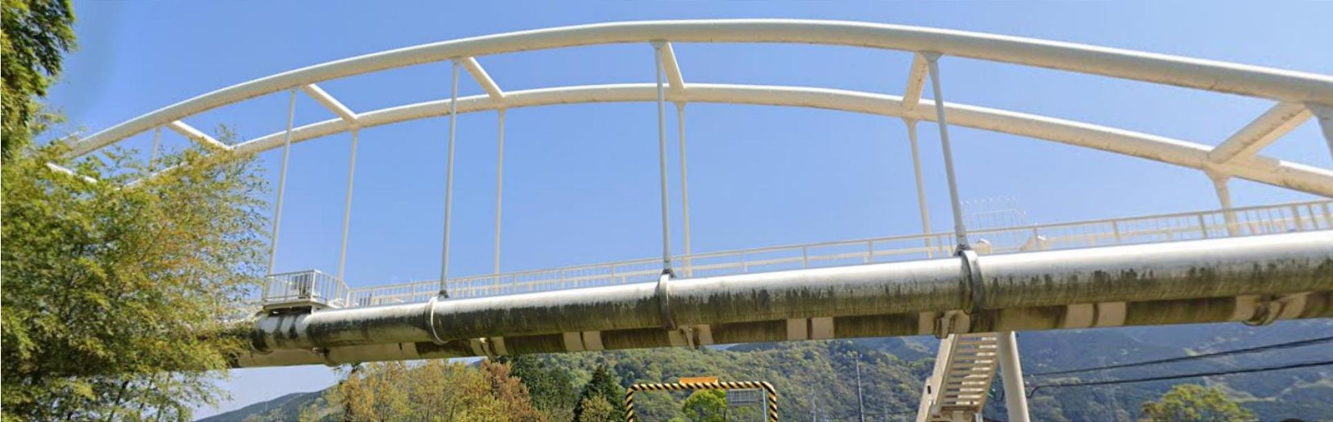
4径間のランガー式水管橋(吊材2×9本)
