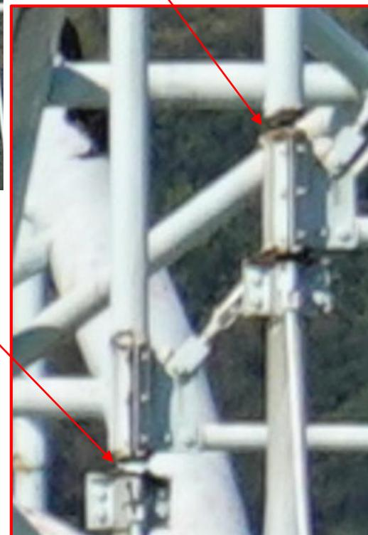
一瞥してわかるような明瞭な破断は視認できないが、望遠＋拡大により凝視すれば視認可能である。
