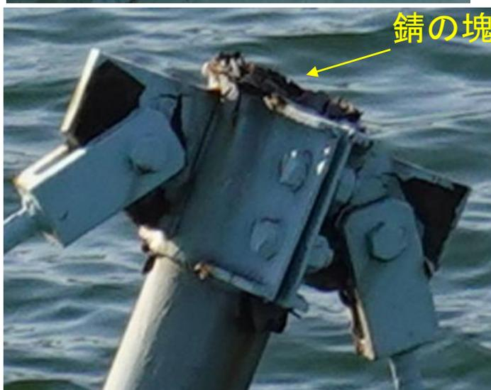
・吊材SS4L(下流側)とSS4U(上流側)は振れ止め定着部金物の上下で破断している。腐食が著しく、破断面は錆が層状・塊状になっており、残存耐力はゼロに等しいと推察する。
