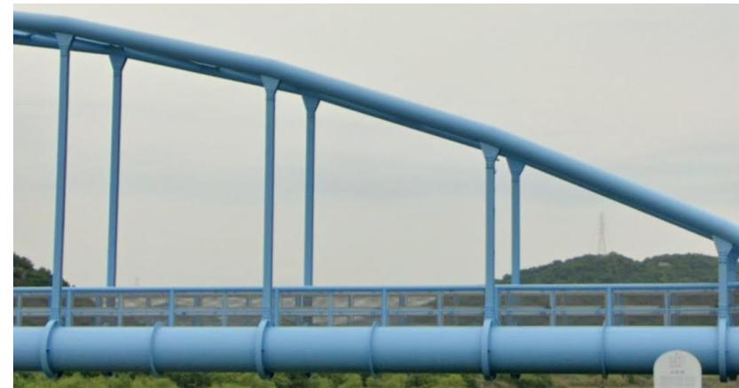
ランガー式6径間。錆認知できず、汚れなし。
