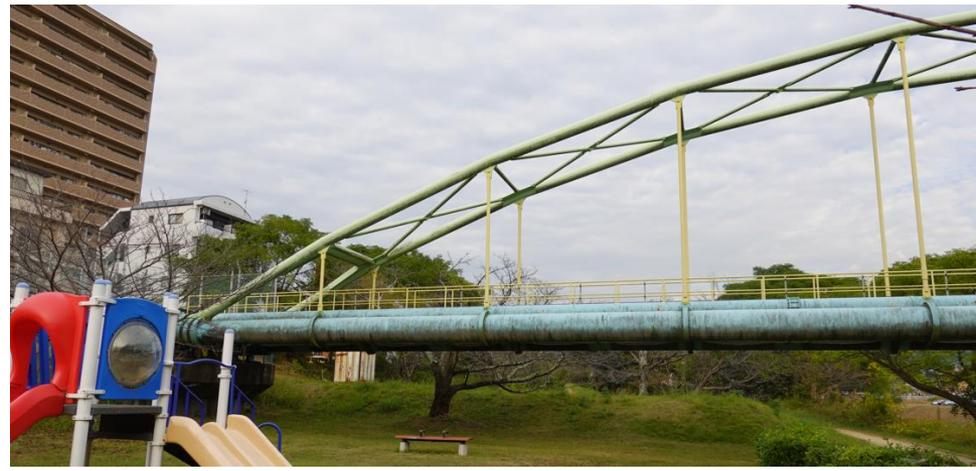
アーチリブ、吊材、吊材定着部、通水管
