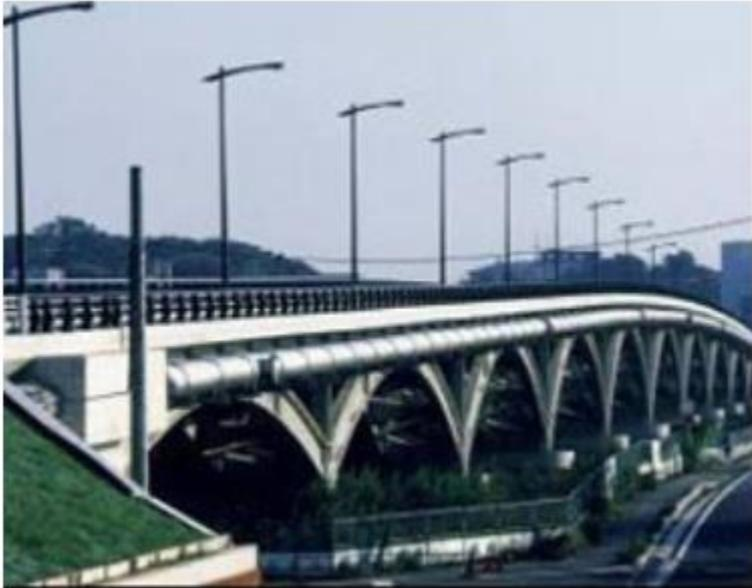
写真-9 添架形式（桁外）
