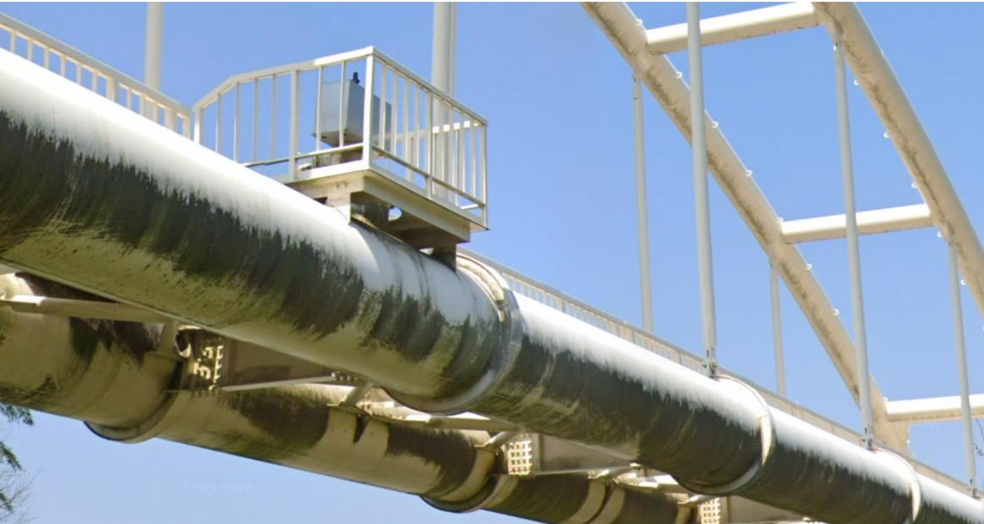
アーチリブ、吊材、吊材定着部、通水管補剛リング、いずれも健全。
