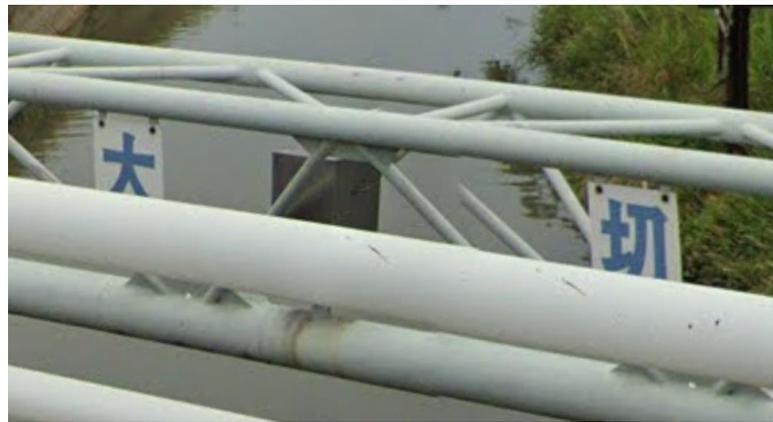
三角形トラス補剛水管橋。一見してトラス材、格点接合部、水管のいずれも健全に見える。
