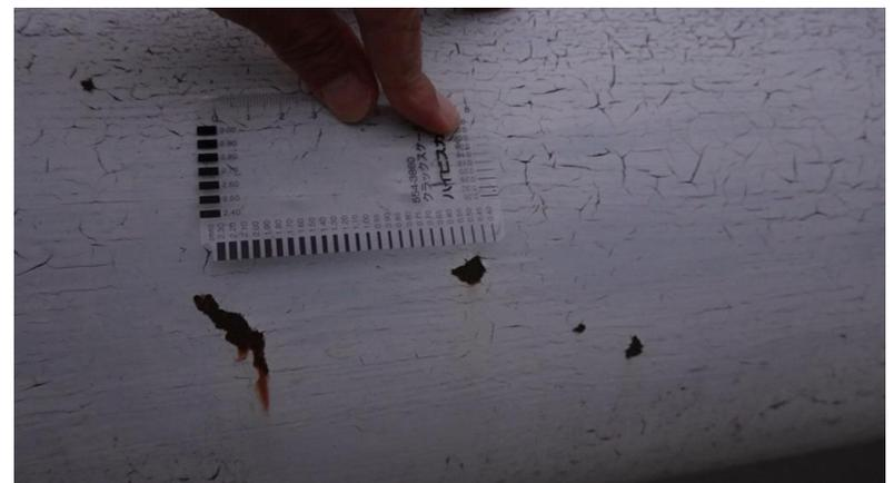
三角形トラス補剛水管橋。現地に行けば、塗装の劣化、外的起因の錆などが確認できた。
