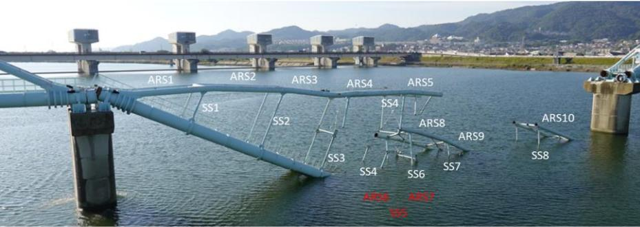
ARS3とARS4との間でアーチリブが座屈して下に曲がっている。これは、吊材SS1からSS3までは生きていたのに対して、SS4以降の中央部は破断したからである。
