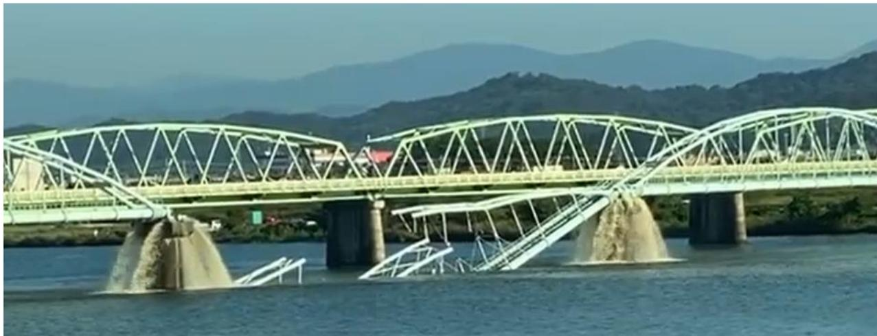
16:07にツイッターに投稿された動画では、崩落径間の隣接する送水管から落水する様子が映っている
