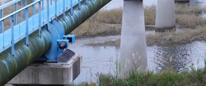
通水管の上の歩廊の錆や、通水管の側面・底面に汚れは鮮明に見える。
