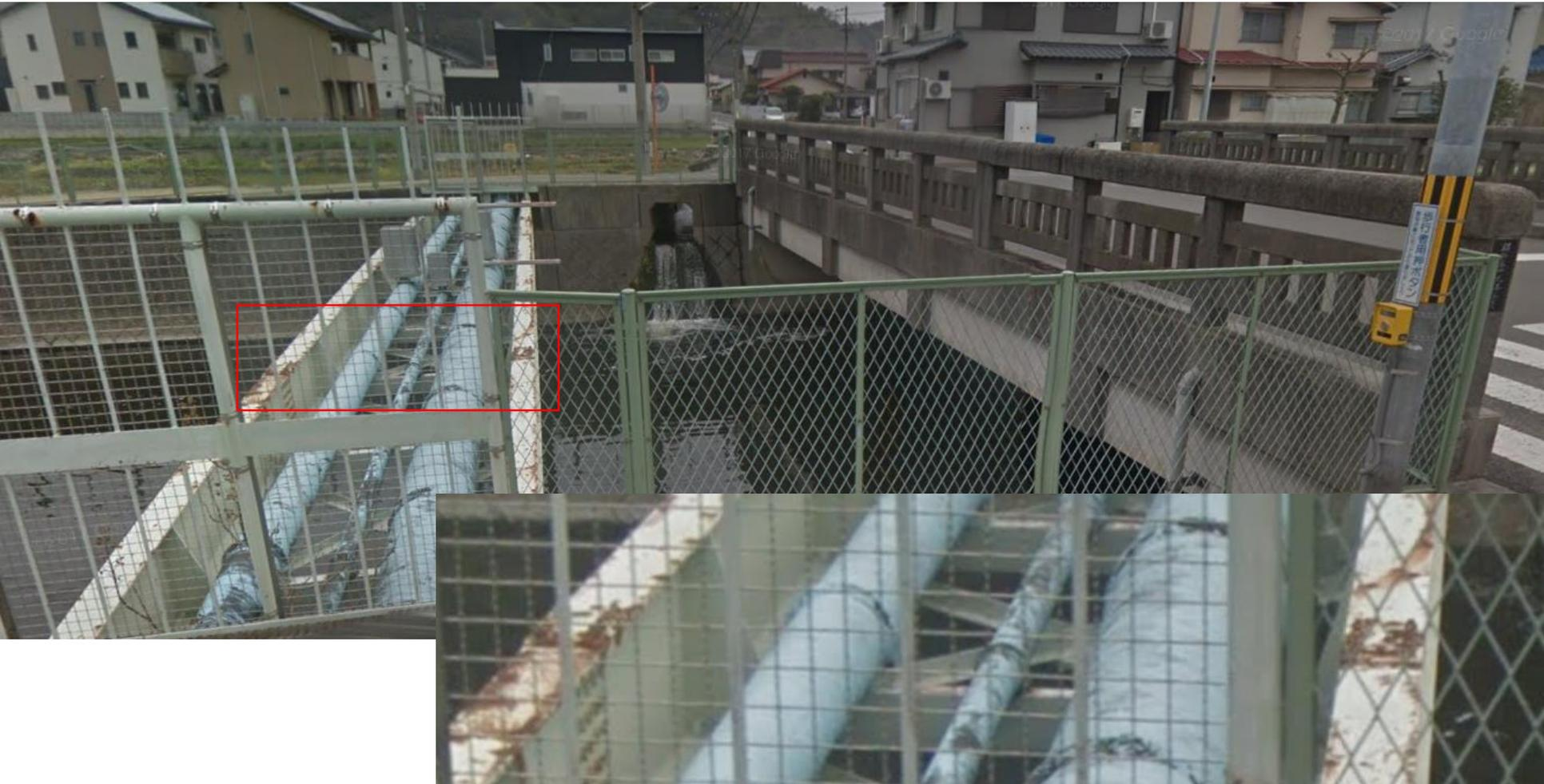
補剛形式ではなく、ラック形式。ラックとなる鋼桁橋の桁に錆が出ています。
