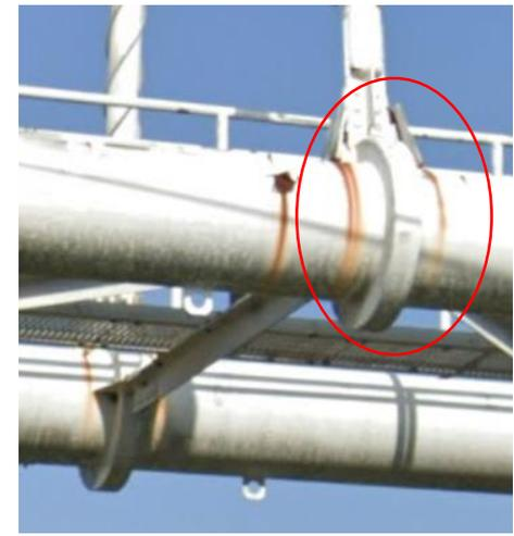
アーチリブ鋼管の吊り材定着部上方に2面对の錆(溶接部か)が複数見られる。
