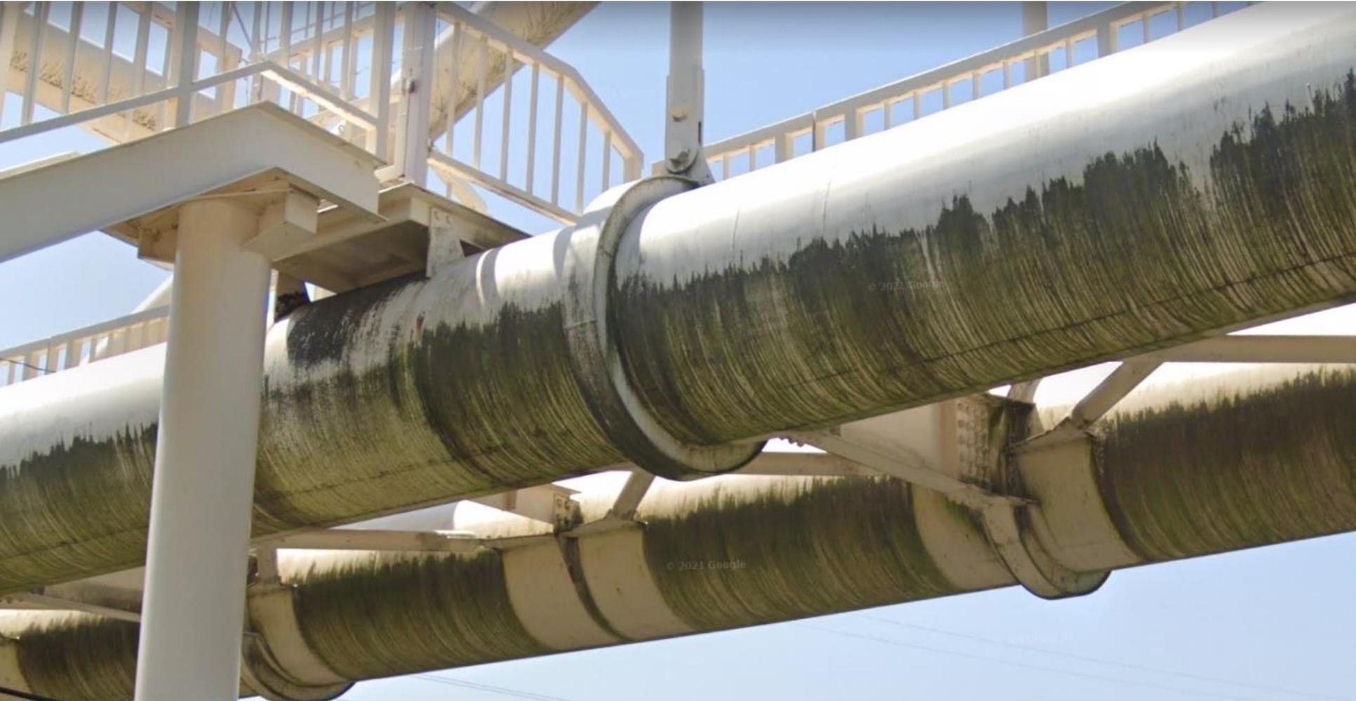
2本のランガー桁としての通水管を水平につなぐ、サポートリングと下横桁の接続部も健全。
